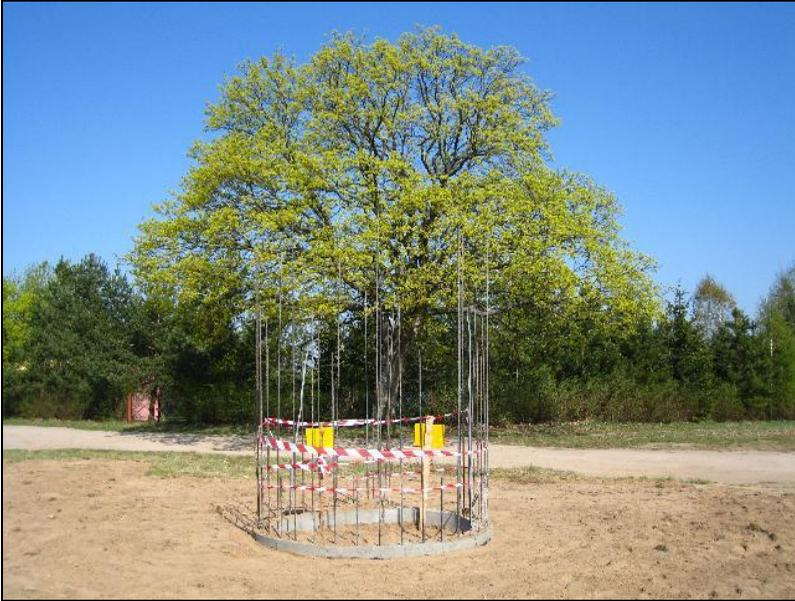
*Aus dem fertigen Fundament ragen die Bewehrungen
